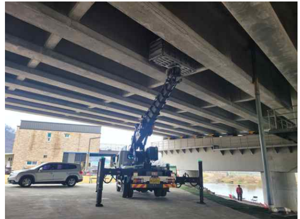
고소작업차를 이용한 근접조사
