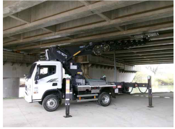
고소작업차를 이용한 근접조사
