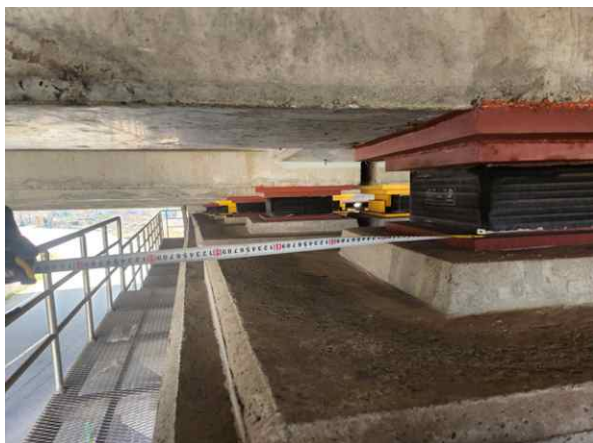
받침장치 연단거리 측정
