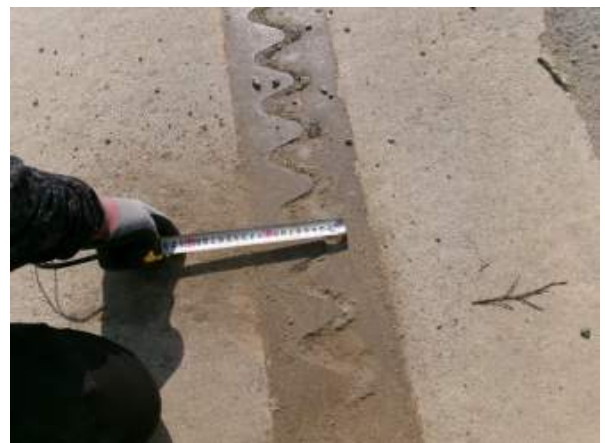
신축이음 이동량 측정
