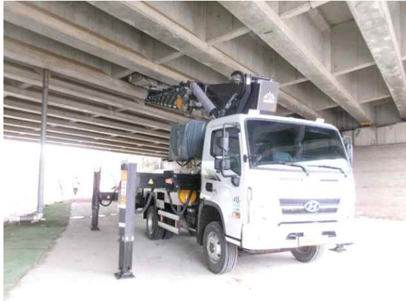
고소작업차를 이용한 근접조사
